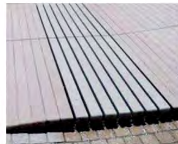
Les fils d'eau de l'allée principale Réservations dans le béton
