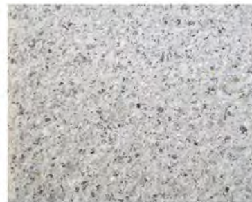
Muret Béton préfabriqué
