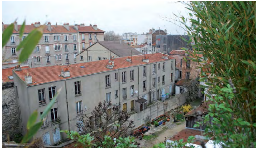
10 Vue depuis le coeur d'ilôt vers la parcelle du 200 rue Etienne Marcel
