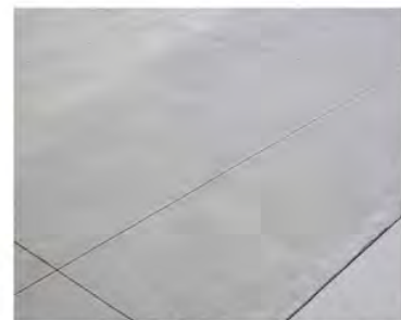
L'allée principale du jardin Béton hydrosablé
