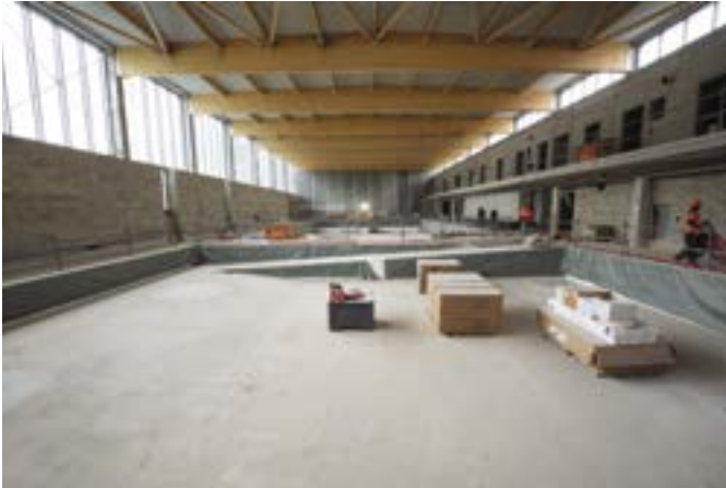
Travaux dans la nouvelle piscine, juin 2026.
