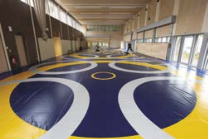
Travaux dans la nouvelle salle de sports de combat, juin 2026.
