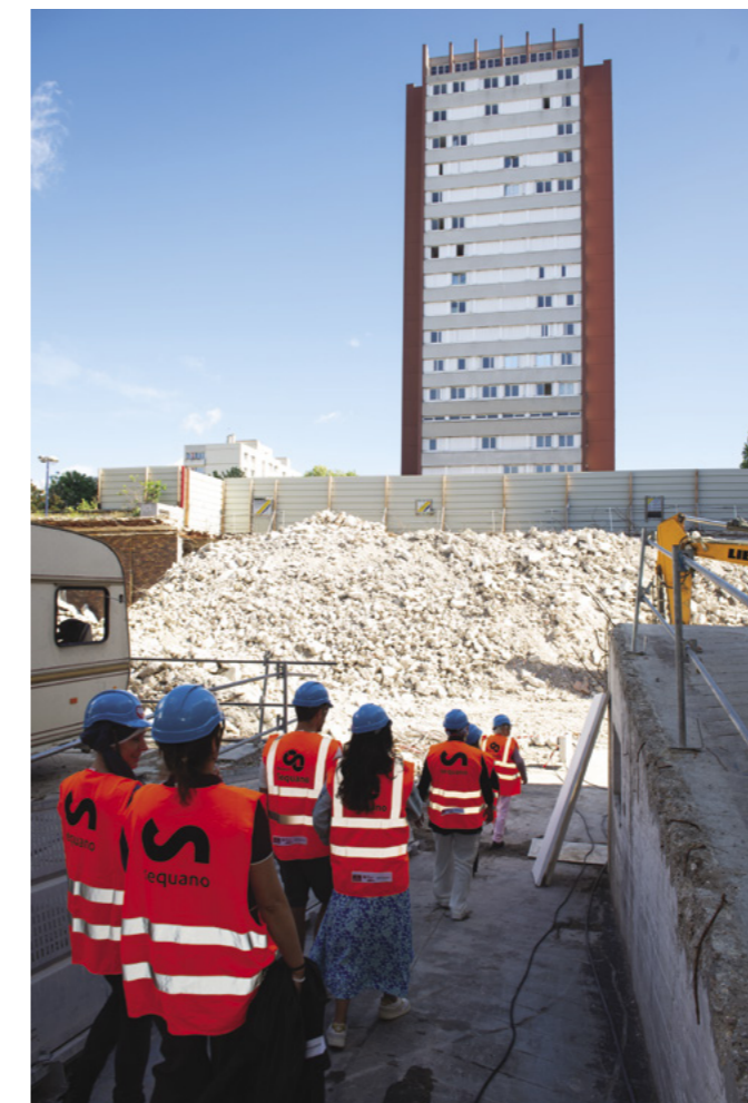
Le béton récupéré sera recyclé et utilisé notamment pour les remblais du futur conservatoire.
