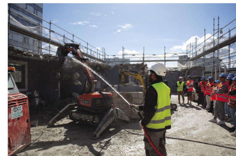
La technique de grignotage a permis de limiter les nuisances sonores pour les riverains.
