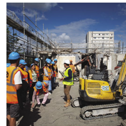
Le rythme de démolition du bâtiment situé au 18, rue Pierre-et-Marie-Curie était d'un à deux étages par semaine.
