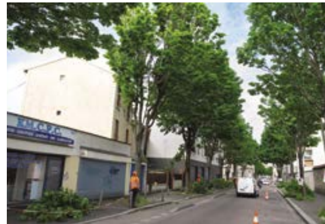
Un élagage d'un alignement d'arbres, avenue Raspail.
