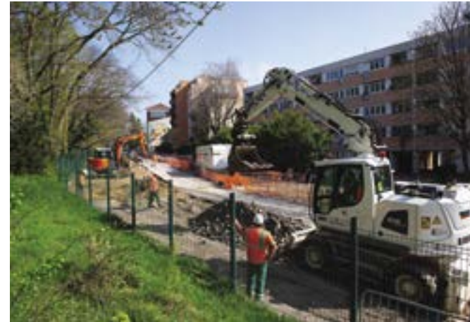
Les travaux du Grand Chemin, rue Sadi-Carnot.
