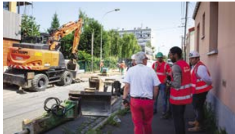
Tony Di Martino, Maire de Bagnolet, se rend sur le chantier de la rue des Rigondes qui durera deux mois.
