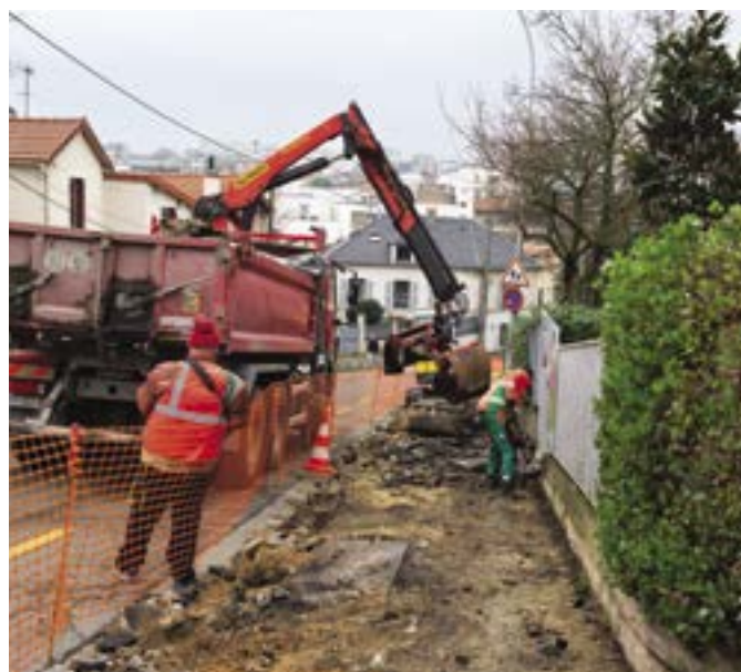
Réfection du trottoir au niveau de la crèche Lénine.
