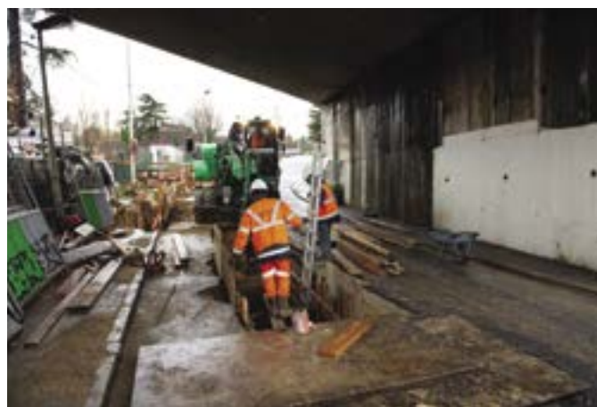
Changement des canalisations, rue Jean-Jaurès.
