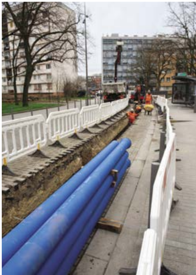
Remplacement des canalisations d'eau potable, rue Raymond-Lefebvre.
