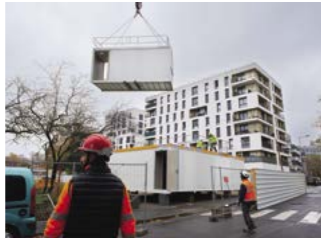
Assemblage de la base de vie pour la construction de l'école Pêche-d'Or.
