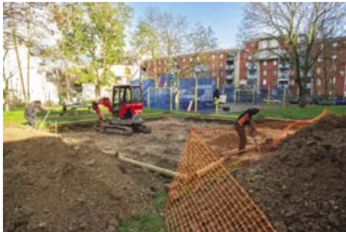
Travaux d'installation d'une aire de jeu, rue Louise-Michel.
