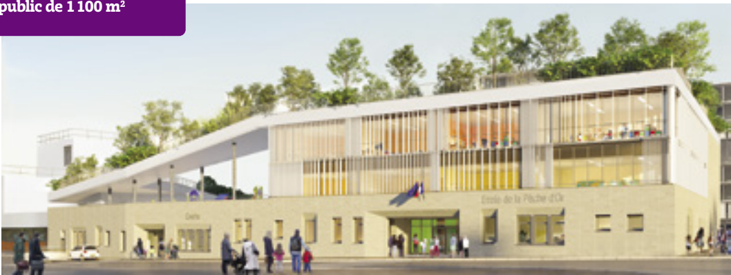
© Photos Daudré-Vignier & Associés architectes - KDSL
