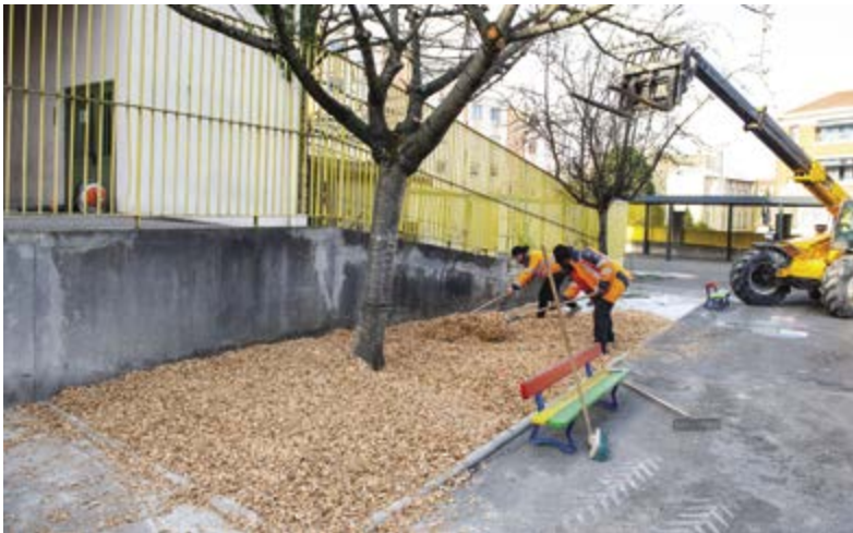
Débitumisation partielle de la cour de l'école maternelle Travail.
