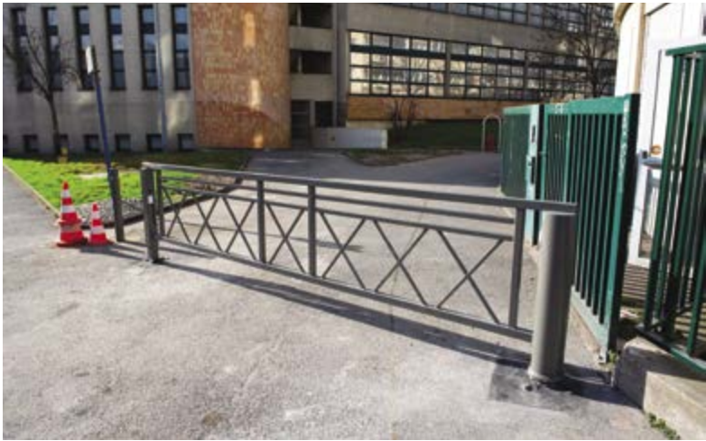
Nouvelle barrière installée, passage des Italiens.
