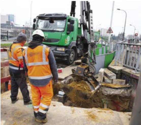
Travaux de rénovation du réseau de chaleur, avenue Gambetta.
