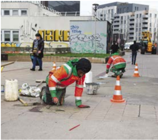
Travaux de réfection de la dalle des Mercuriales.
