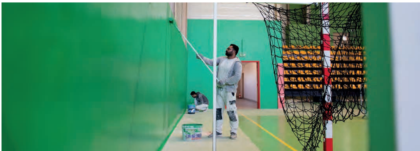
Peinture, réfection des portes coupe-feu, pose d'une nouvelle alarme incendie... des travaux sont en cours au gymnase Cifarielo-Fanara.
