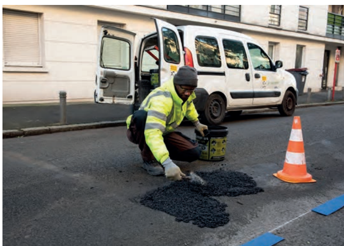
Comblement d'un nid de poule sur la chaussée rue Francisco-Ferrer par un agent de la Voirie.
