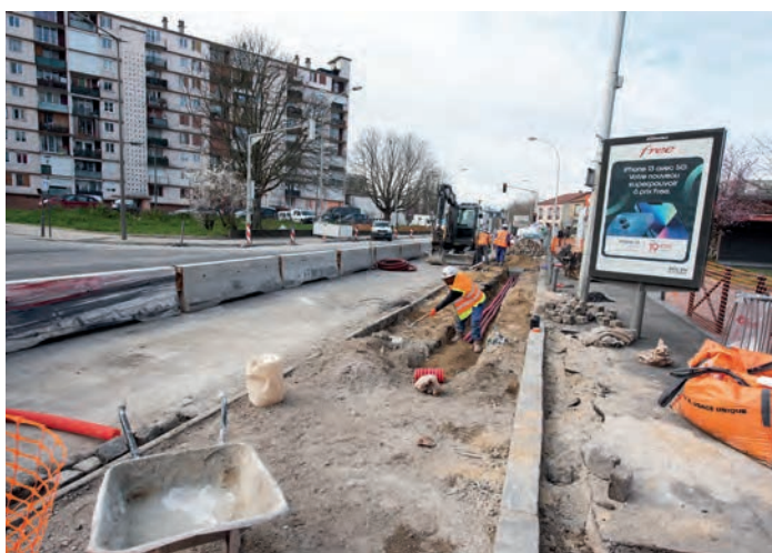
Les travaux d'aménagement avenue Stalingrad comprenant de nouvelles pistes cyclables se poursuivent.
